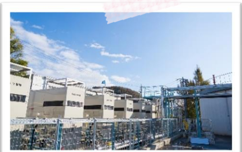
秋里下水処理場 バイオマス発電所
