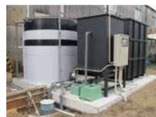
廃水処理設備
