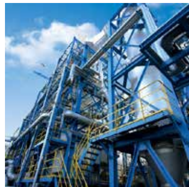
江島工場の焼却炉
