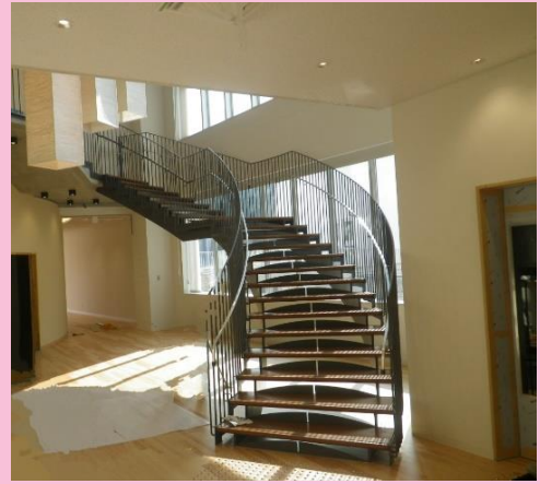
金物加工部門・手摺施工
