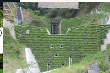
壁面緑化 (鳥取県内砂防堰堤)
