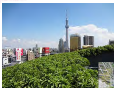
屋上緑化 (都内某ビル)
